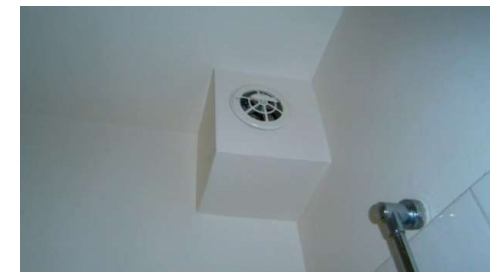
Bouches d'extractions non fonctionnelles
